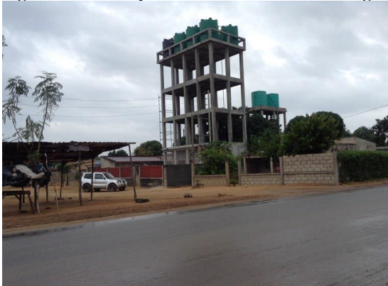
Figura 20 Sistema privado de Abastecimento de água Bairro Ndlavela, Matola
