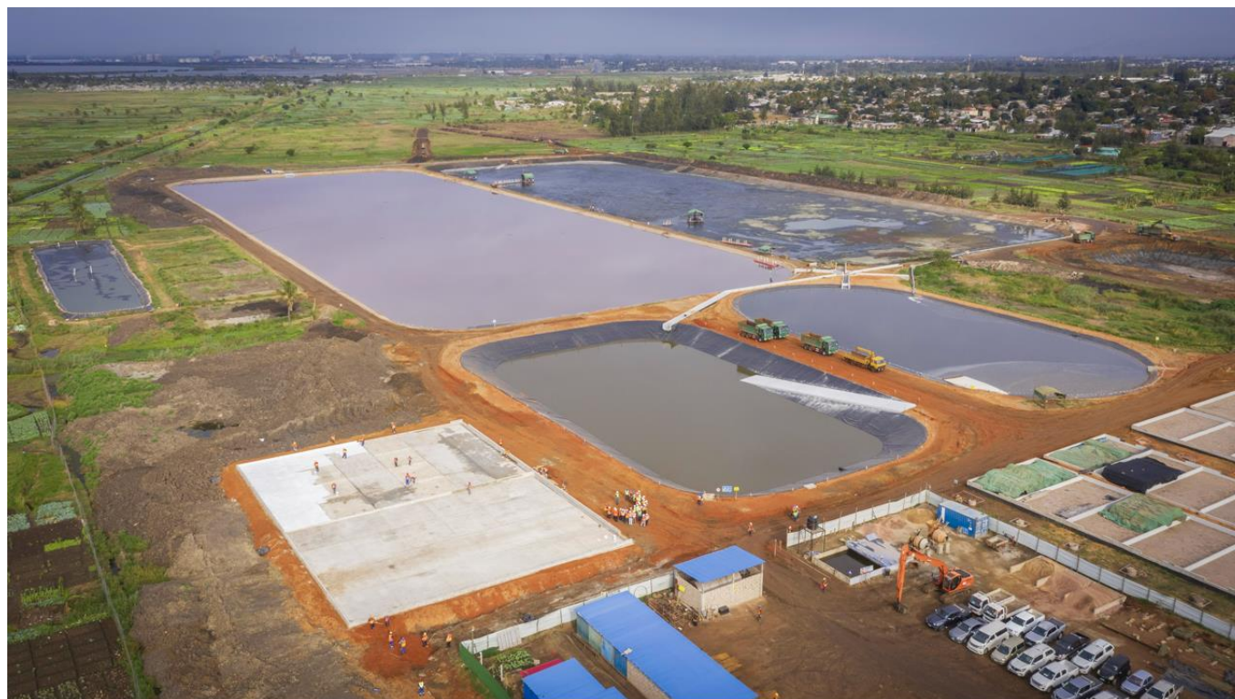
Figura 4 – Vista da ETAR do Infulene – Em obras de reabilitação e ampliação
