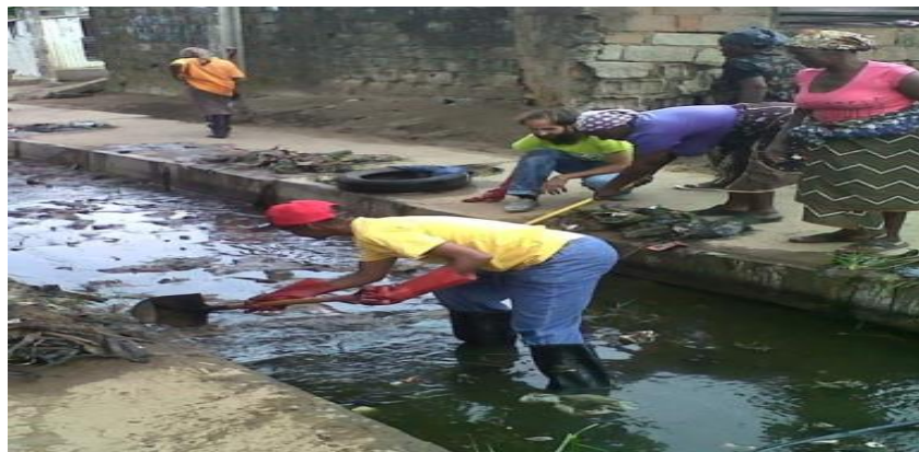
3. Jornada de Limpeza nas Valas de Drenagem na Cidade de Maputo
