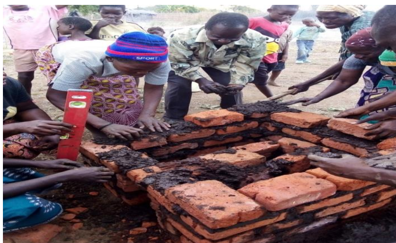
5. Comunidades de Moatize, em plena capacitação prática sobre o fabrico de fogões melhorados
