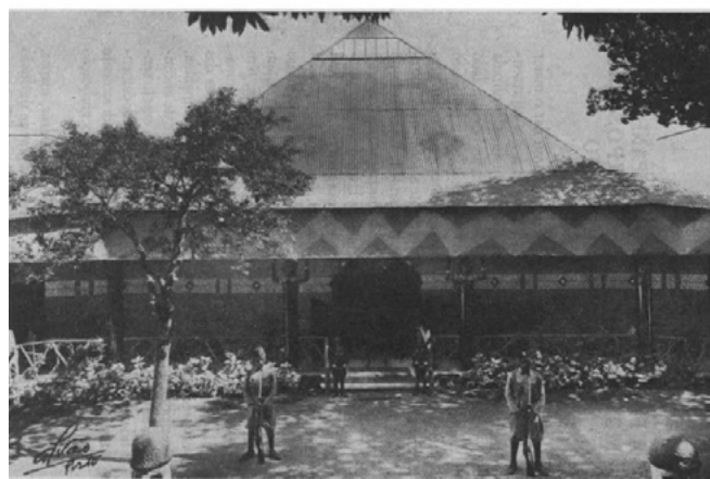
Fachada do Pavilhão (parte central)
