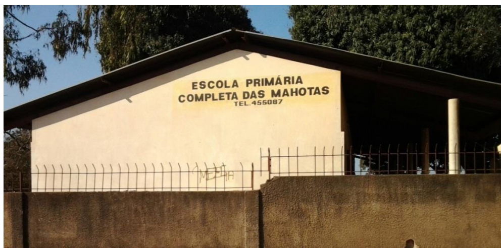
Figura 1: Vista parcial da EPC das Mahotas
