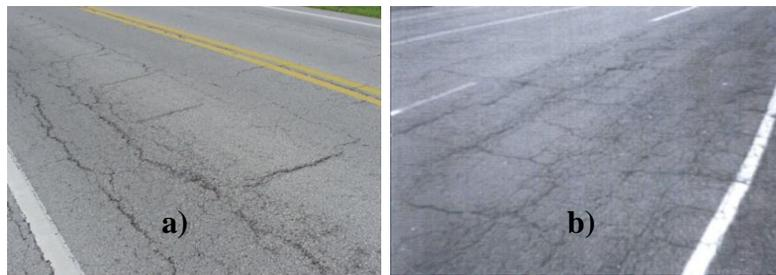
**Figura 7.** Trincas em bloco: a) trincas em bloco transversais de média severidade; b) trincas em bloco transversais de alta severidade (Fonte: Williams *et al.*, 2006).
