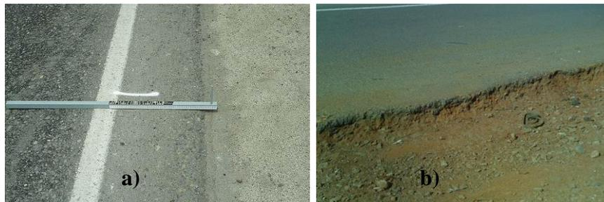
**Figura 12.** Figura. Desnível entre a pista e o acostamento (*line-to-shoulder dropoff*): a) desnível entre a pista de rolamento o acostamento pavimentado; b) desnível entre a pista de rolamento o acostamento não pavimentado. (Fonte: Machado, 2013; Miller & Bellinger, 2014).
