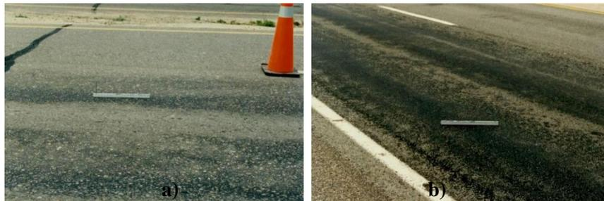
**Figura 16.** Exsudação (*bleeding*): a) exsudação de média severidade; b) exsudação de alta severidade. (Fonte: WSP Canada Limited, 2020).
