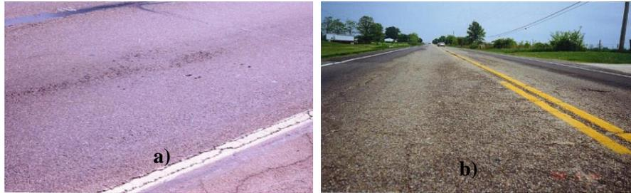
**Figura 18.** Desgaste (*raveling*): a) de média severidade; b) de alta severidade (Fonte Williams *et al.*, 2006).
