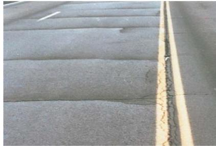
**Figura 9.** Trincas de reflexão, de alta severidade (Fonte: Miller & Bellinger, 2014).
