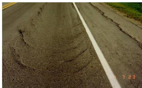
**Figura 10.** Escorregamento (*shoving*) do pavimento asfáltico (Fonte: WSP Canada Limited, 2020).
