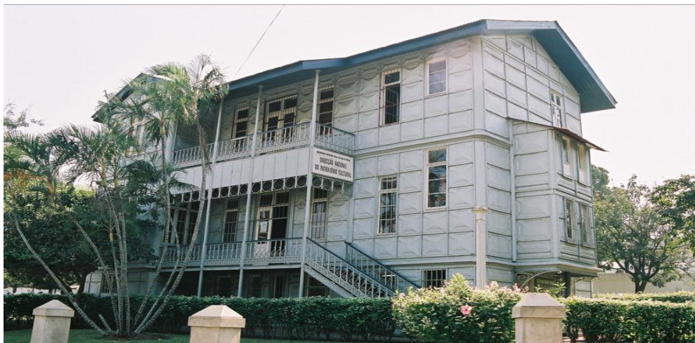
Figura 2: Edifício da Casa do Ferro
