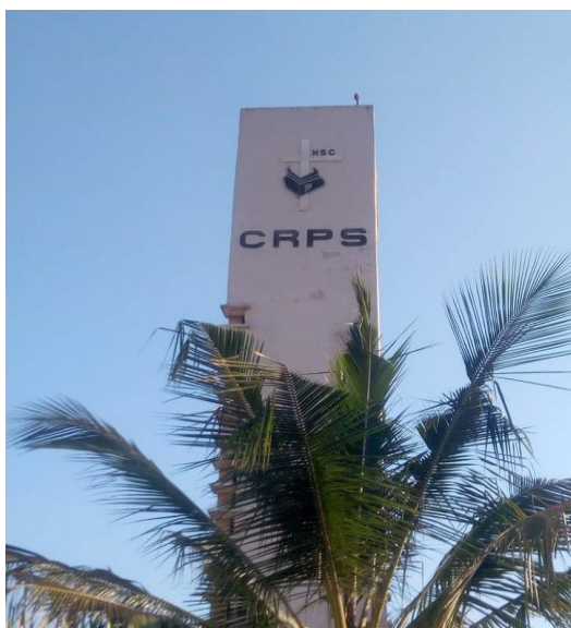
Figura 1: Foto da torre do CRPS
