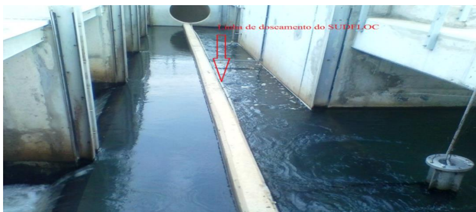
Figura 6: Ponto de doseamento do polieletrólito (SUDFLOC), na câmara de mistura
