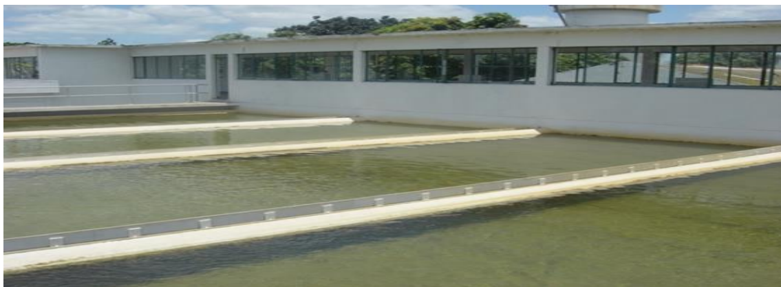
Figura 9: Ilustração dos filtros Aquazur V em uso na ETA do Umbeluzi
