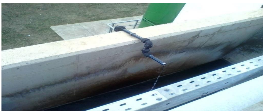
Figura 5: Ponto de doseamento do coagulante (SA) na câmara de mistura
