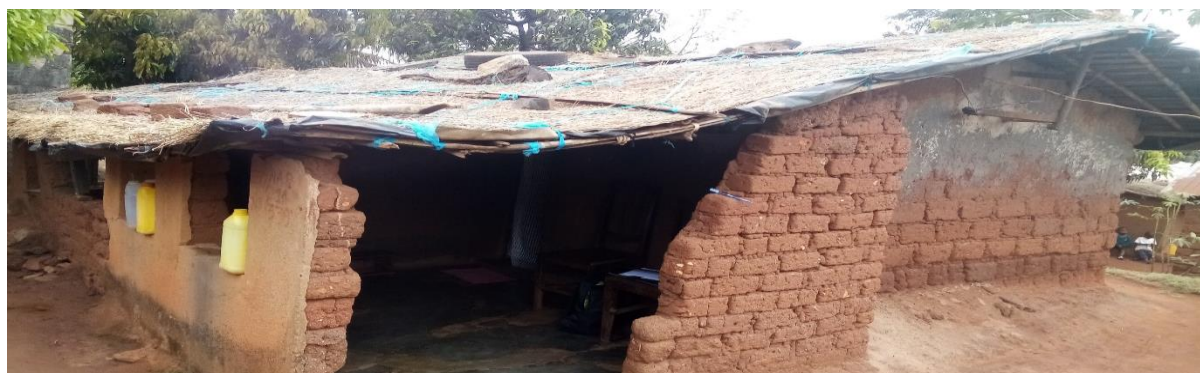
Fig. 3. Uma residência feita à base de bloco burro e argila, com cobertura de plástico, bambú amarrado em tiras provenientes de redes mosquiteiras e palha (foto tirada pela autora, 25 de Novembro de 2019).
