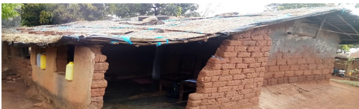
Fig. 7: Casa de Gina feita com base em bloco burro (foto tirada pela autora, 25 de Novembro de 2019).
