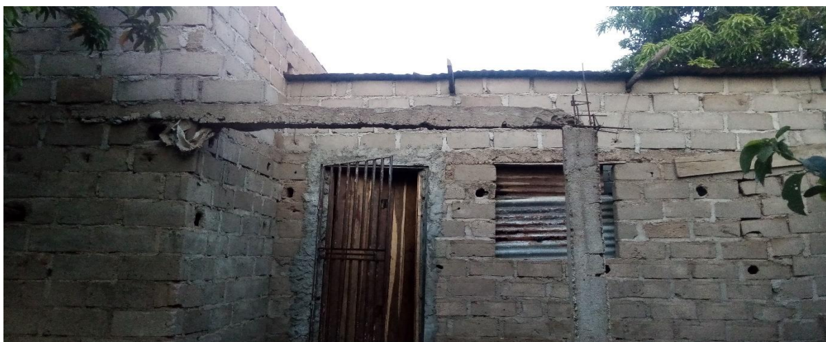
Fig. 6: Habitação construída à base de bloco de cimento, areia, ferros e cobertura de chapa de zinco (foto tirada pela autora, 07 de Dezembro de 2014).
