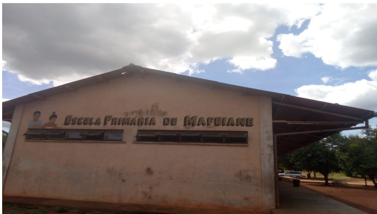
Figura 1: Escola primária de Mafuiane - Namaacha
