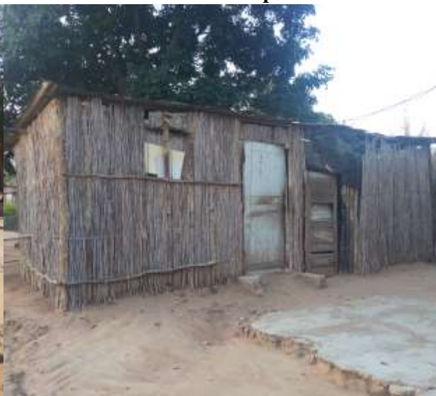
Imagem. nº. 8.1.2. Casa feita de caniço com cobertura de chapas de zinco
