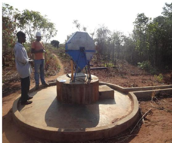
Foto 2: Fonte de água equipada com bomba de corda avariada em Muapula
