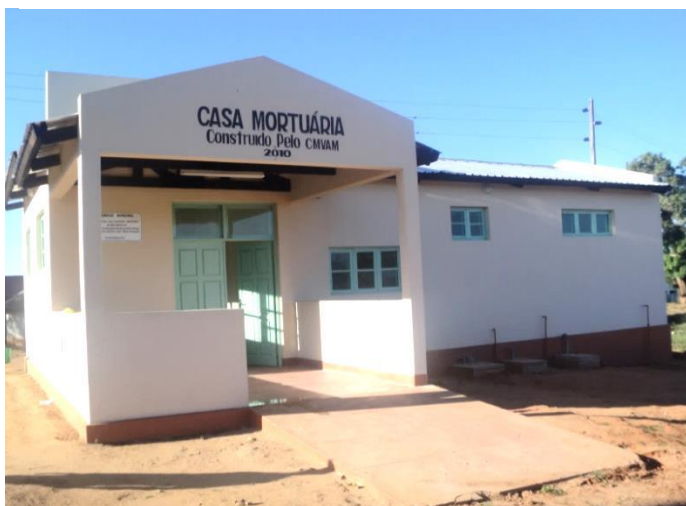
Imagem 3: Casa Mortuária e Posto de Saúde construídos pelo CMVAM
