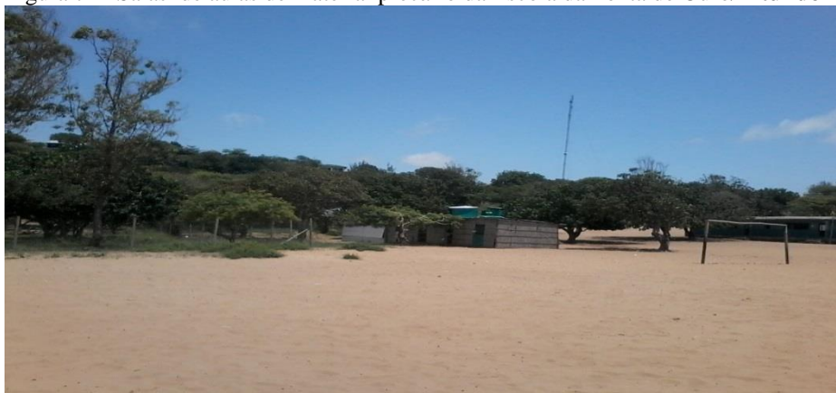
Figura 7 – Salas de aulas de material precário da Escola da Ponta de Ouro/Zitundo
