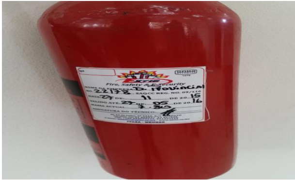
Foto 18: Imagem ilustrativa dos extintores com prazo de validade do agente extintor expirado Fonte: autor
