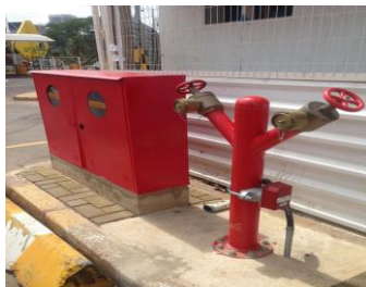
Figura 42: Imagem ilustrativa de um hidrante industrial com duas expedições Fonte: www.google.co.mz
