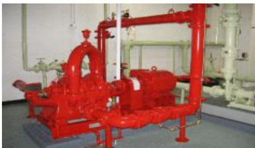
Figura 44: Imagem ilustrativa de uma sala de bombas para o sistema de incêndio Fonte: http://www.rwengenharia.eng.br
