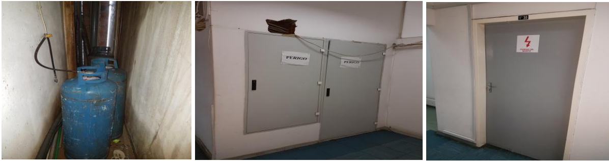
Foto 14: imagens ilustrativas de ausência de sinalização em zonas de risco Fonte: autor
