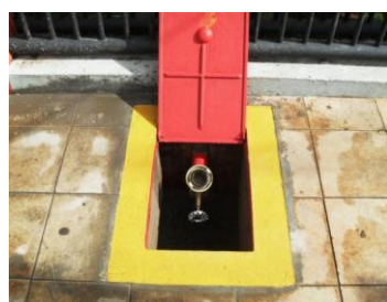
Figura 43: Imagem ilustrativa de um hidrante de recalque Fonte: www.google.co.mz
