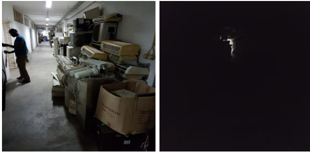
Foto 16: Corredor da cave do edifício onde funciona o economato, com iluminação parcial e sem iluminação de emergência
