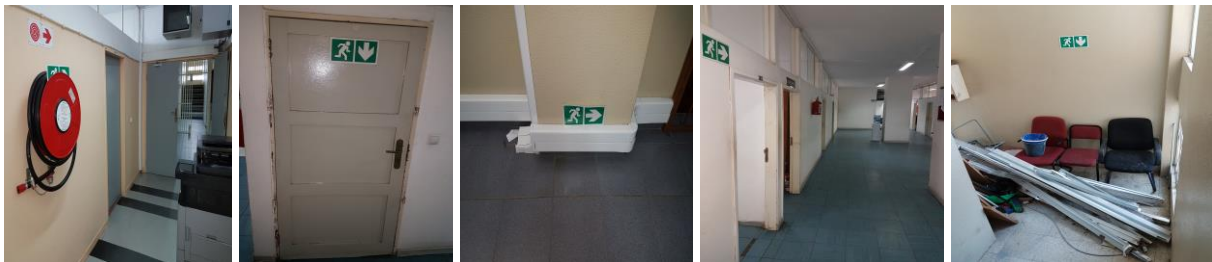
Foto 13: Imagens indicativas da necessidade de revisão da implantação da sinalização de orientação e salvamento Fonte: autor
