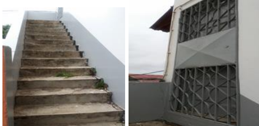
Foto 6: Pormenor da escada do edifício com acesso vedado
