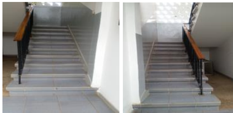
Foto 7: Pormenor das escadas do edifício com corrimão
