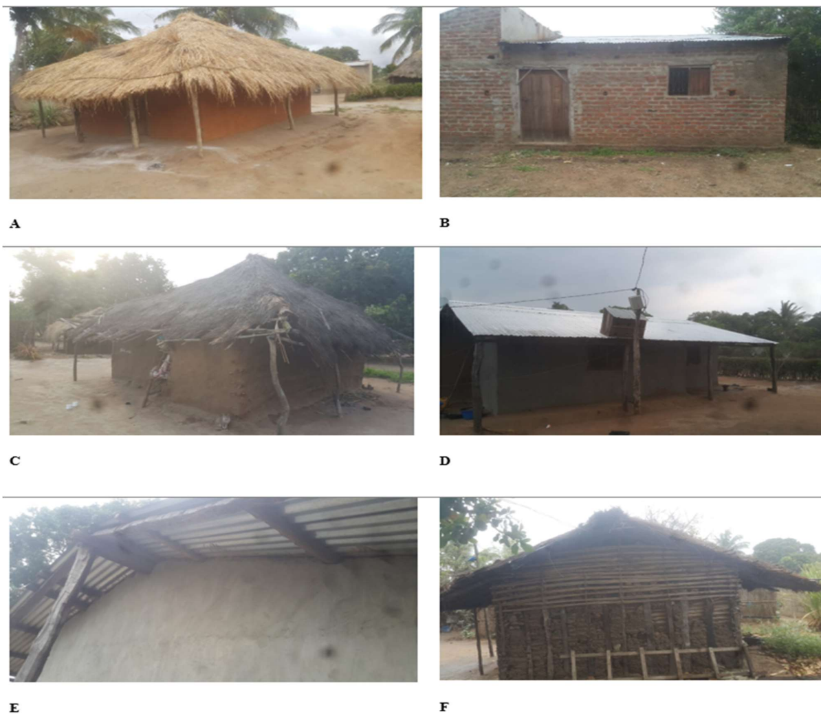
Figura 3: Exemplo de estruturas avaliadas nos três postos sentinelas da Província da Zambézia: A -Quadrado com telhado de capim/Bloco cru/lama, B -Rectangular com telhado de zinco/Tijolo queimado, C -Quadrado com telhado de capim/Bloco Cru/lama, D -Rectangular com telhado de zinco/Bloco de Cimento, E -Abba ou Beiral Fechado, F -Abba ou Beiral Aberto.
