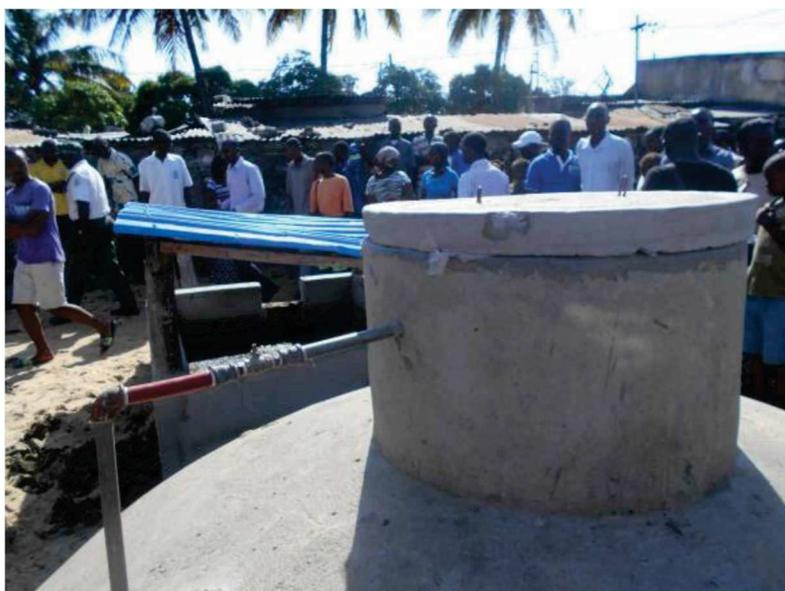
Fig. 3 – Biodigestor de laje de betão armado (ALER.org).
